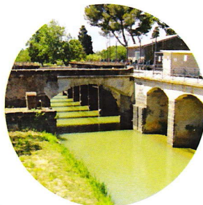
Ouvrage de franchissement du Libron par le Canal du Midi
