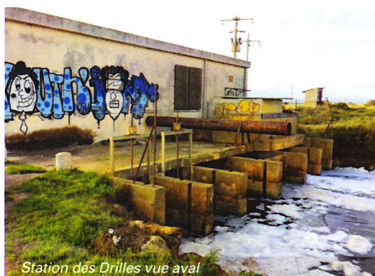
Station des Drilles vue aval
