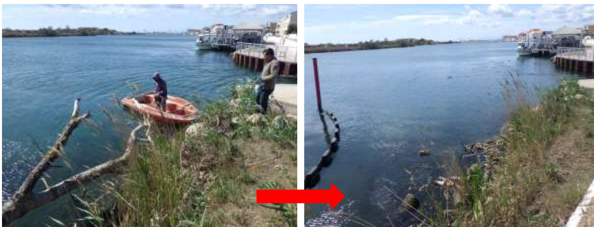
Suppression d'un arbre échoué sur la digue à l'entrée du port de Jean GAU
