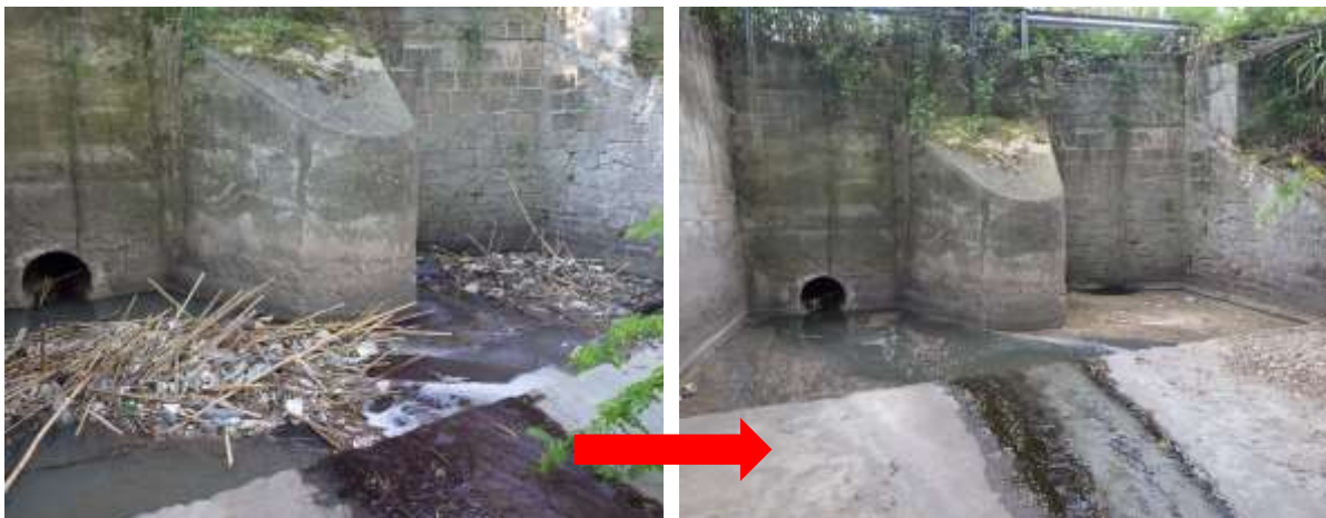
Siphon du Rec d'Ariège au droit du Canal du Midi : suppression d'amas de déchets flottants et collecte des déchets flottants
