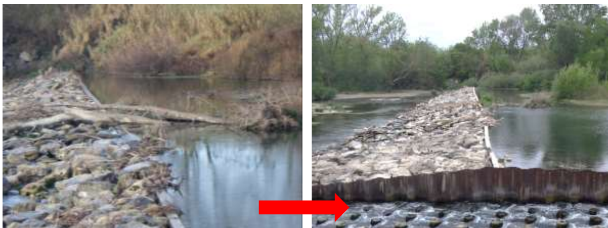
Suppression d'arbres sur le seuil de Thézan les Béziers et nettoyage de l'entrée de la passe à poisson
