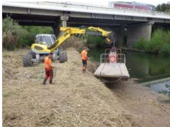
Transfert et mise à l'eau des pontons et bateau pousseur sur le secteur 4 à l'aval de l'A9
